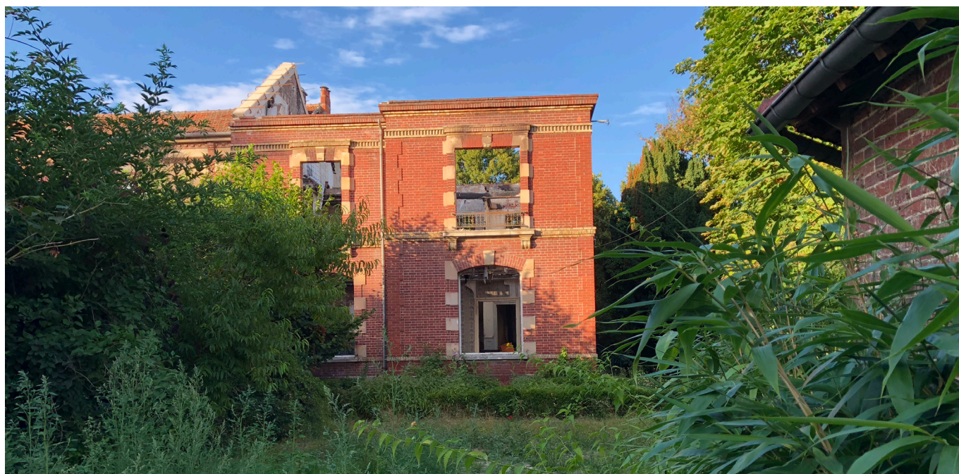
Une maison vient d'être incendiée rue de l'Orangerie alors qu'elle était inhabitée et que l'électricité était coupée: notre quartier va-t-il connaître les mêmes dérives que certaines banlieues trop connues? Non à la « banlieusardisation » des Avenues! Photo Éric Georgin.
