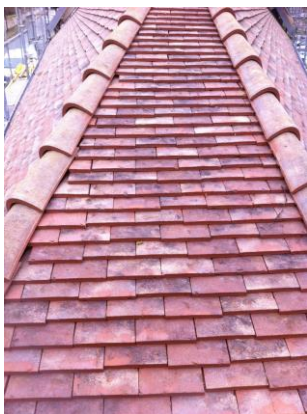
Réfection de la toiture en tuiles vieilles
