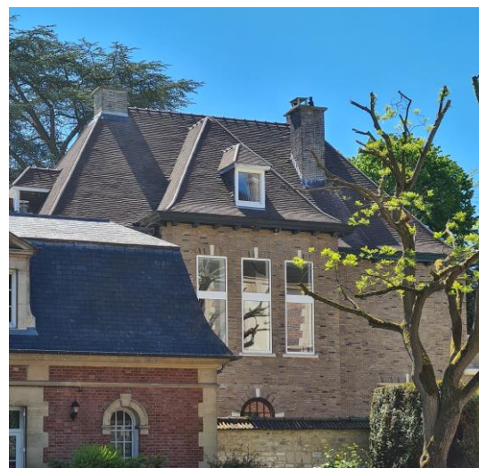
Disparition des petits carreaux et pose de vitrages réfléchissants
