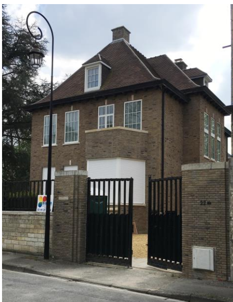
Nouvelles menuiseries en aluminium
