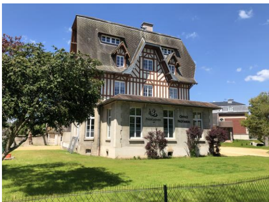
Remise en état des bâtiments et du jardin
