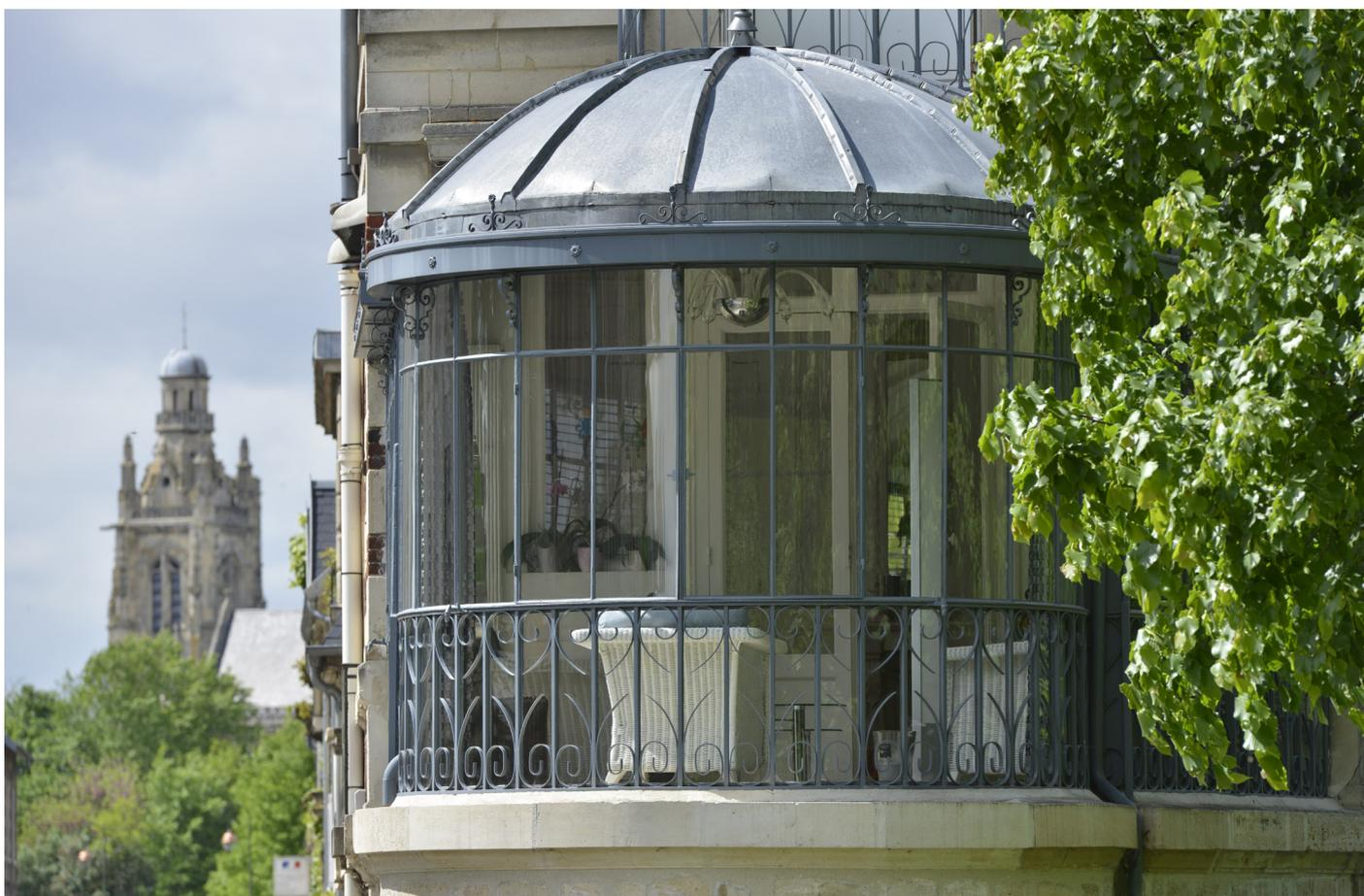
Maison en poue de bateau à l'angle de l'avenue Royale et de la rue Eugène Jacquet. La restauration de la véranda a été réalisée avec le souci du détail et de la bonne exécution. Un simple observateur ne peut imaginer les difficultés de mise en œuvre d'une feuille de zinc, peu souple, sur une surface à double courbure. A noter également les éléments décoratifs sur le bandeau mouluré qui fait office de gouttière... sans oublier les glaces courbes sur mesure ! Très belle exécution.
